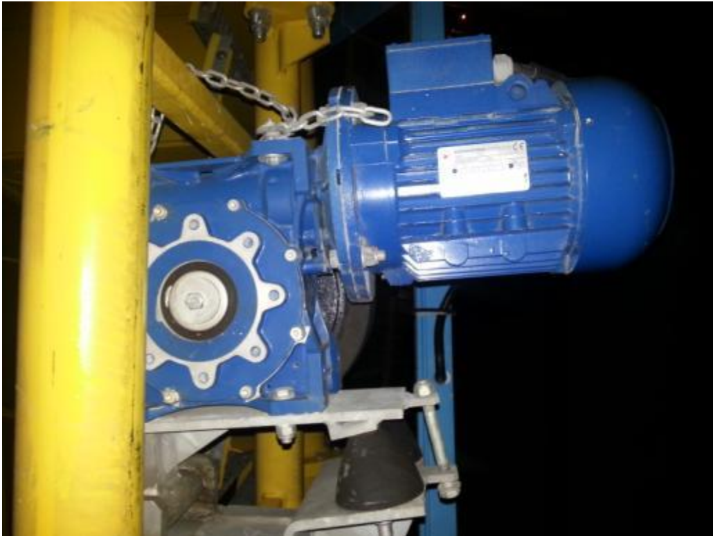
照片 7:維修完成後之減速機及馬達。
