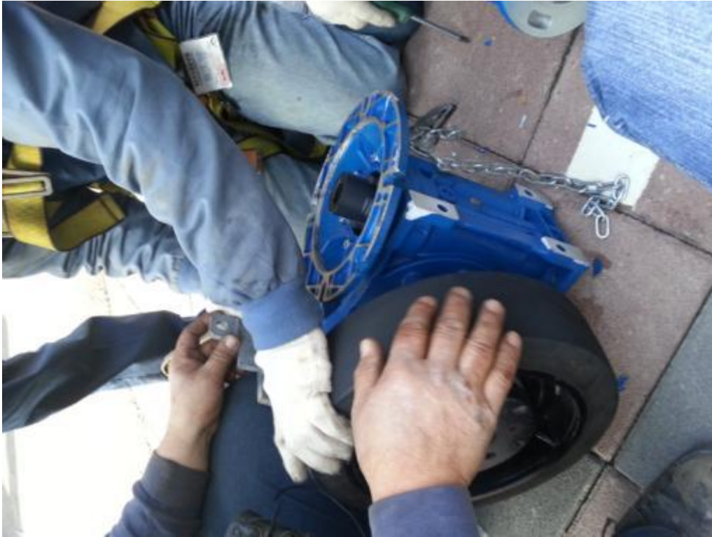
照片 6-2:減速機維修處理中
